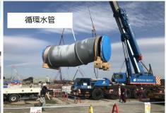
⑥:護岸エリア 発電機を回した蒸気冷却用の海水を取り 入れる取放水管は、直径3mを超える大き
