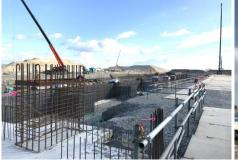
④: 貯炭建屋エリア 発電に使用する石炭の貯炭用の建屋基礎を 動式破砕機で細かく砕き、地盤改良等の材 建設しています。建屋は100m×200 支える基礎は、重量や振動に耐えられる 料として構内で有効活用し、産業廃棄物及 mで、10日分の石炭を貯炭します。屋内 さであるため、工場製作後,海上輸送する で貯炭することで粉塵の飛散を防止します。ことで、大型車両の低減を図っています.
