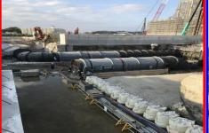
循環水(海水)配管設置(①変圧器エリア)ヒーターの上荷(②タービンエリア) 分割して搬入してきた循環水(海水)配管 を接続し据え付けを行っています。循環水 (海水)を使用し、蒸気を間接的に冷却 しています。
