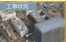
排水処理設備(⑦排水処理エリア) 発電所内で使用した排水を貯めるための 水槽を建設しています。排水は、いくつ かの工程を経て清浄化して、排水します。
