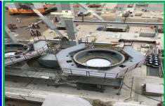
ミルの据え付け(③ボイラエリア) ミルと呼ばれる、石炭を細かく砕く機 器のモータ設置と機器本体の基礎据え 付けが完了しました。次は機器本体を 据え付けを行います。
