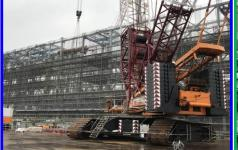
ヒーターと呼ばれる熱交換器をタービ ン建屋3階に上荷(積み上げ)しました。 先月号で紹介した、大型クレーンを使 用上荷(積み上げ)しました。
